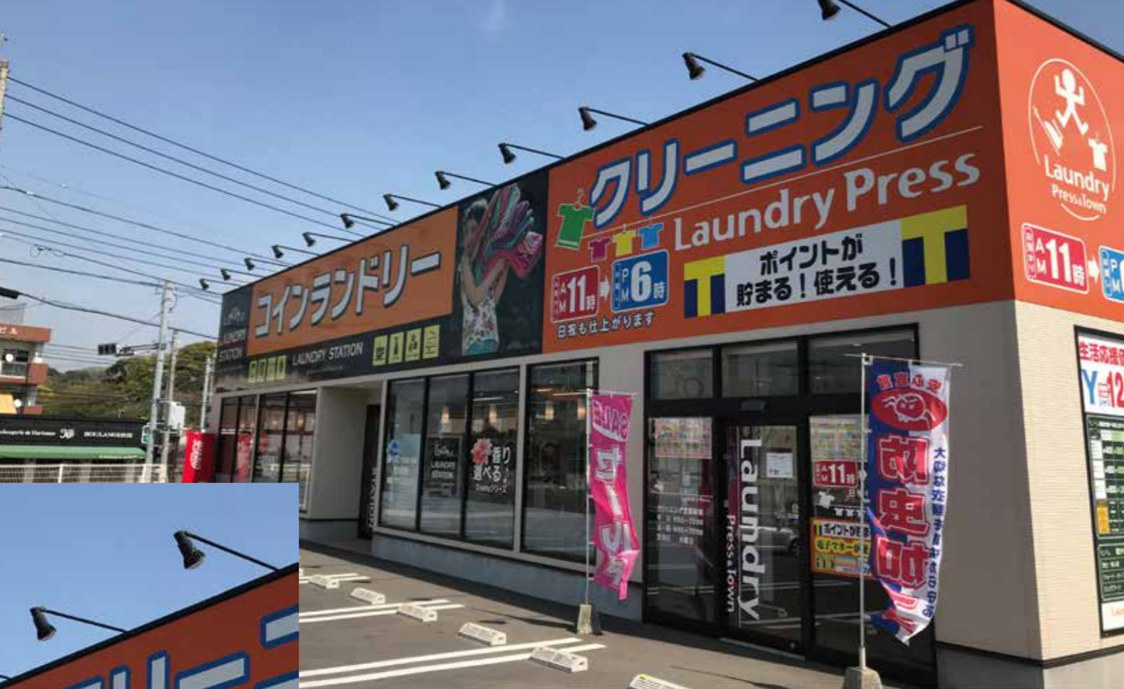
北九州市某店舗施工写真
