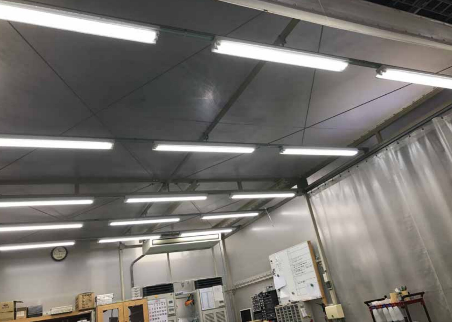
木更津市某工場施工写真
