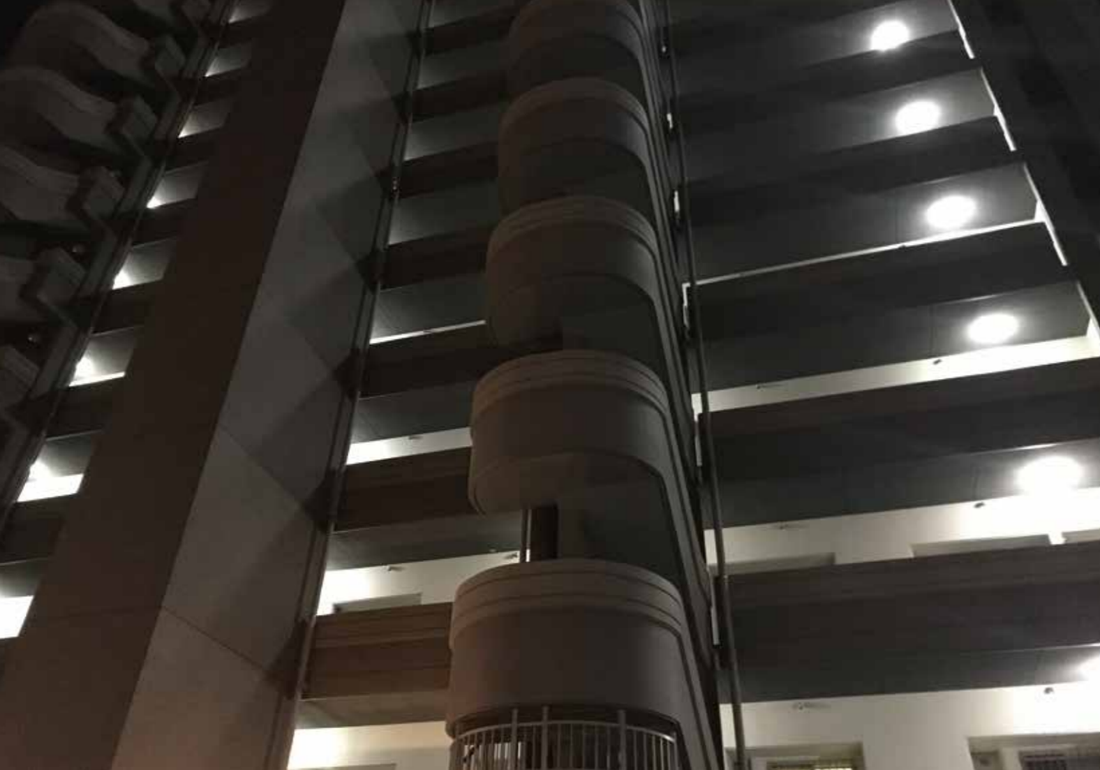
福岡県某マンション施工写真
