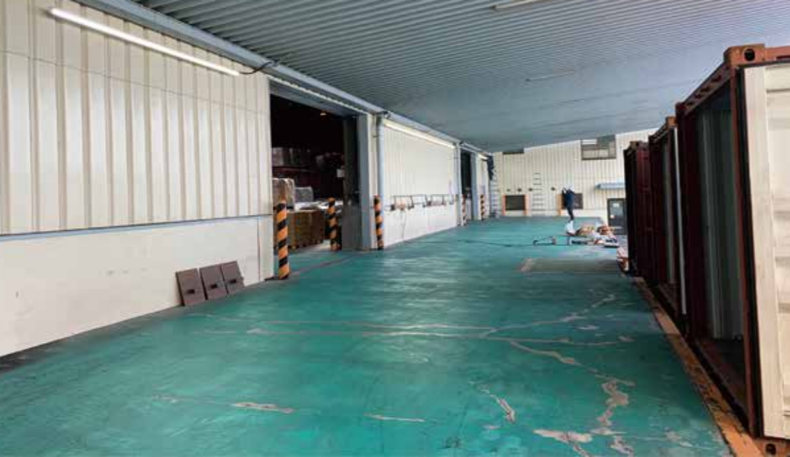
北九州市門司港の倉庫施工写真
