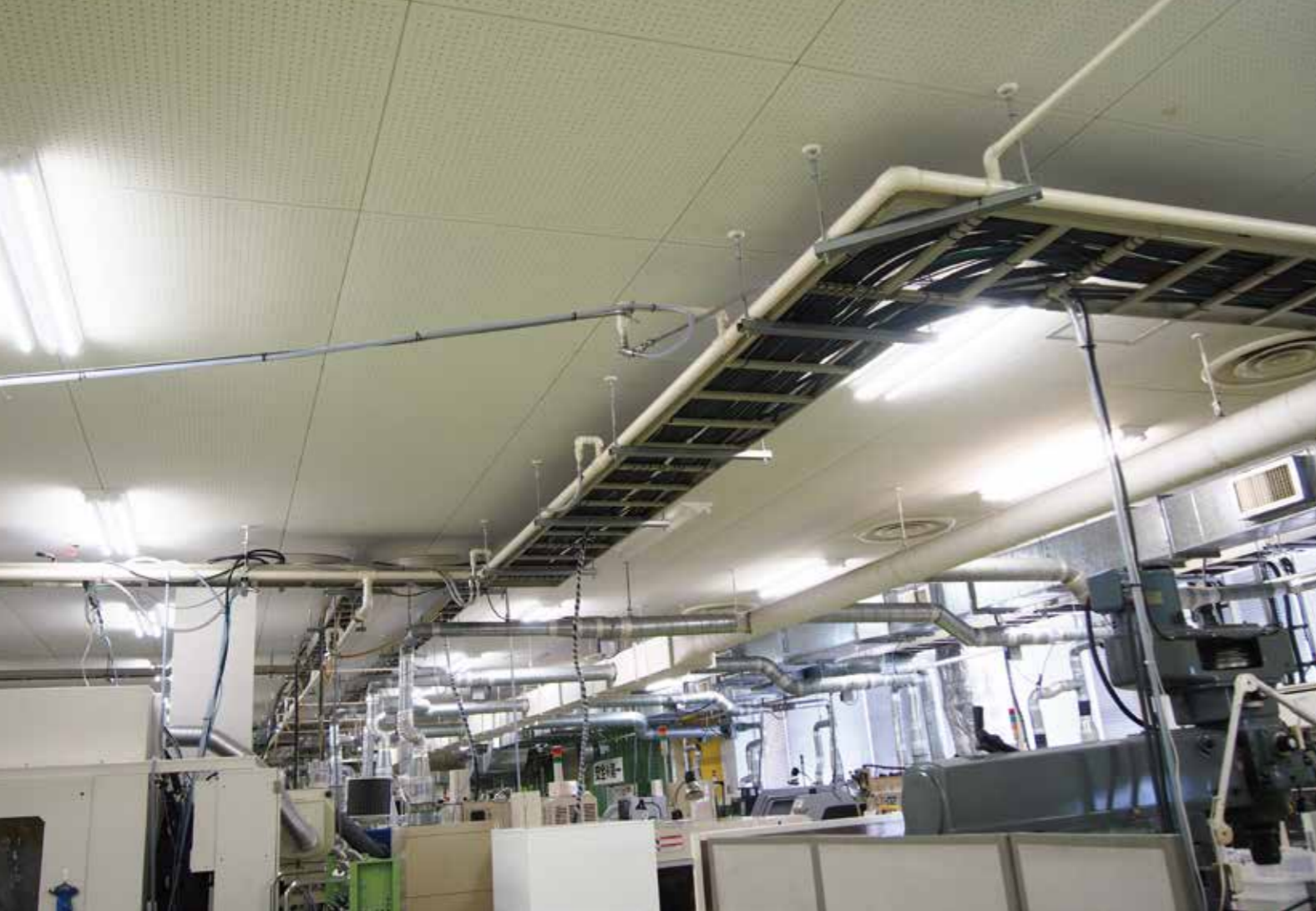
北九州市某工場施工写真
